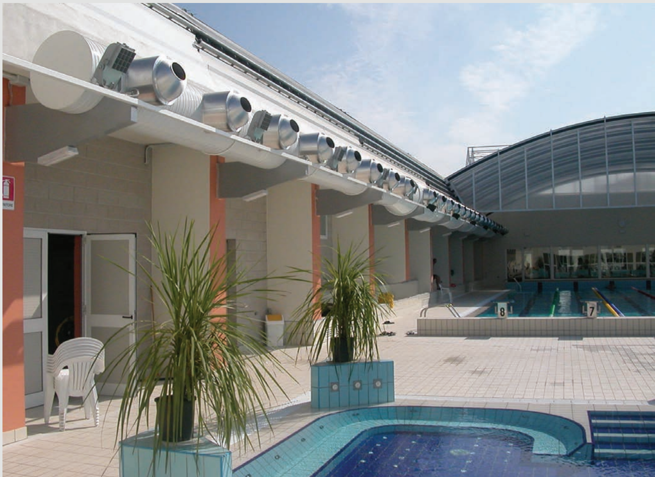
Installation des diffuseurs Perlys® en extérieur dans un centre aquatique.
